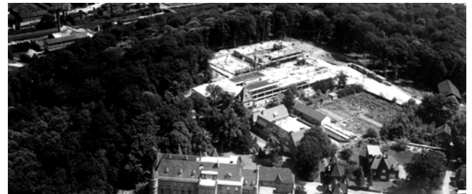
→ Luftaufnahme des Halbergs mit Blick auf den Bau der Sendergebäude (ca. 1961)
